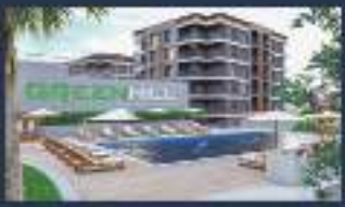
GREENHILL İBF DOĞAN İNŞAAT İZMİR
